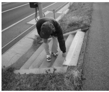
海岸堤防の階段の修繕が決 った箇所。(松江市八東町)
