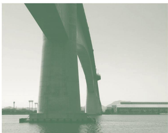
境港市側から江島工業団地を望む
