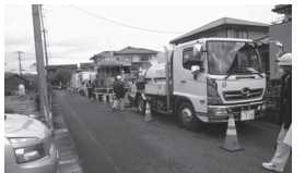
下水道管渠更生工事を視察
