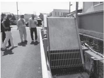
埋川都市下水路の現地調査
